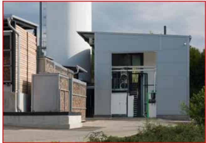
Blockheizkraftwerk - Wärmeleistung 240 kW, Elektrische Leistung 150 kW
